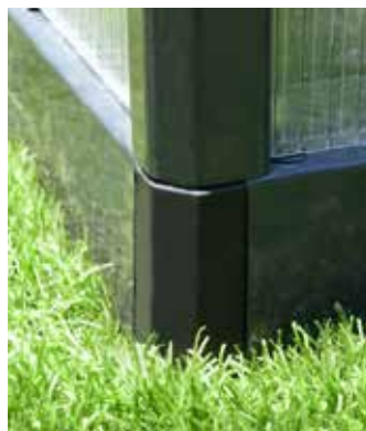
Osnova iz galvaniziranega jekla
