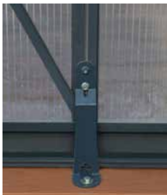
Notranji talni sidrni sistem
